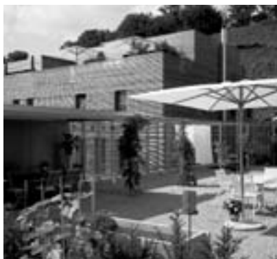
Passivhäuser in Jona_04
