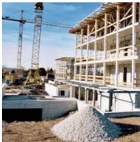
Der Hausverein als Baustelle: Die Fundamente stehen gut, nun gehts an die Feinarbeit.
