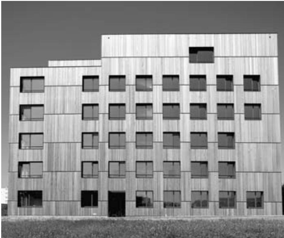
Die Fassade im sechsstöckigen Holzhaus in Steinhausen besteht aus Roter Zeder.
