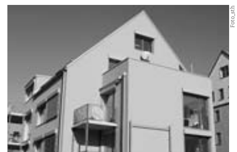
Dank hochkompakten Wärmedämmelementen ist die Aussenwand nur 37 cm dick.
