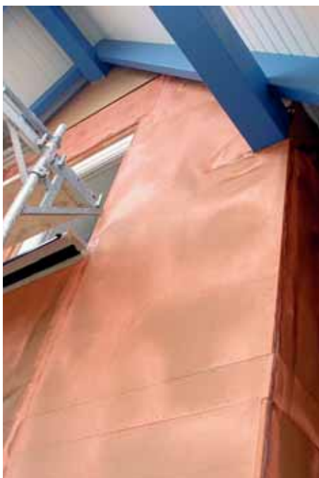
Feinstmaschige Kupfergitter an der Gebäudehülle schirmen gegen elektromagnetische Strahlung ab.
