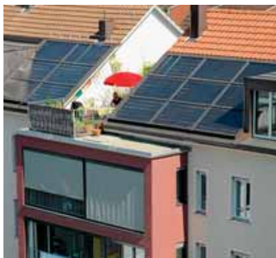
Eine Solaranlage aufs Dach!_6
