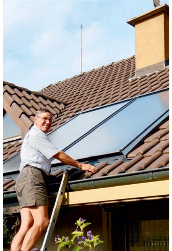
Willi Hardmeier wohnt im Ortskern von Greifensee ZH. Er musste verschiedene Auflagen erfüllen, damit er den Kollektor bauen konnte.
