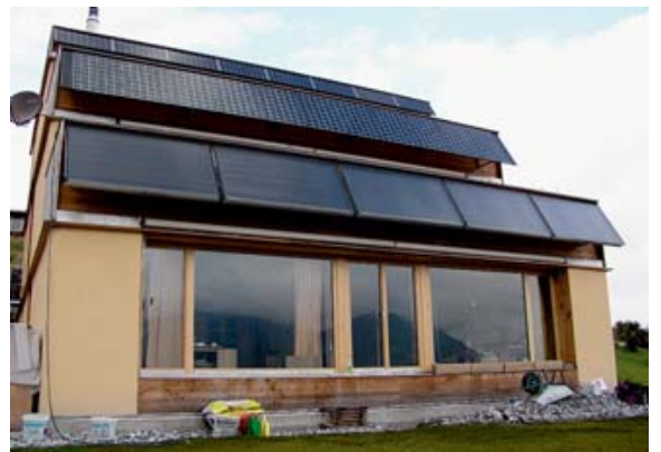
Hochgesteckte Ziele beim Haus in Flerden – immerhin sorgt die Sonne für Warmwasser und Strom.
