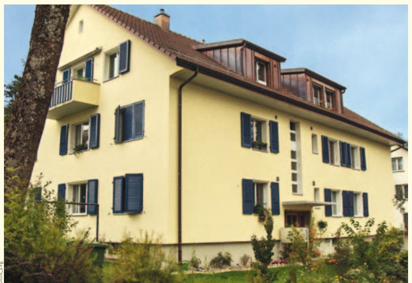
Nach der Sanierung des Mehrfamilienhauses in der Elfenau (Baujahr 1951) sank der Energieverbrauch von 13 auf 8 Liter/m 2 .
