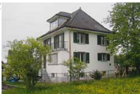
Wohnhaus in Rüti nach der Sanierung in zertifiziertem Minergiestandard.
