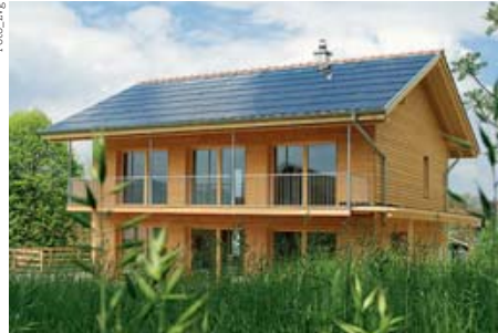
BE Netz installierte im Neubau die thermische Solar- (4,8 m 2 ) und die PV-Anlage (9,6 kWp).
