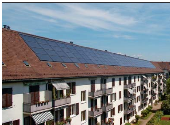
SOLTOP Solartechnik – Installateur SADA – GBM-Genossenschaft + Erdgas Zürich
