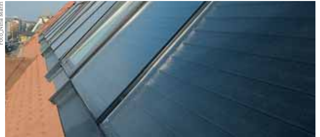
Im Zuge des Dachausbaus wurden auch Solarkollektoren für das Warmwasser installiert.
