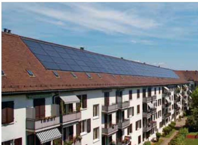
SOLTOP Solartechnik – Installateur SADA – GBM-Genossenschaft + Erdgas Zürich
