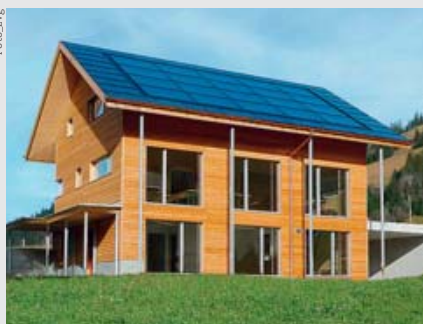
Das Energiedach dieses Einfamilienhauses in Zweisimmen liefert Warmwasser und Strom.
