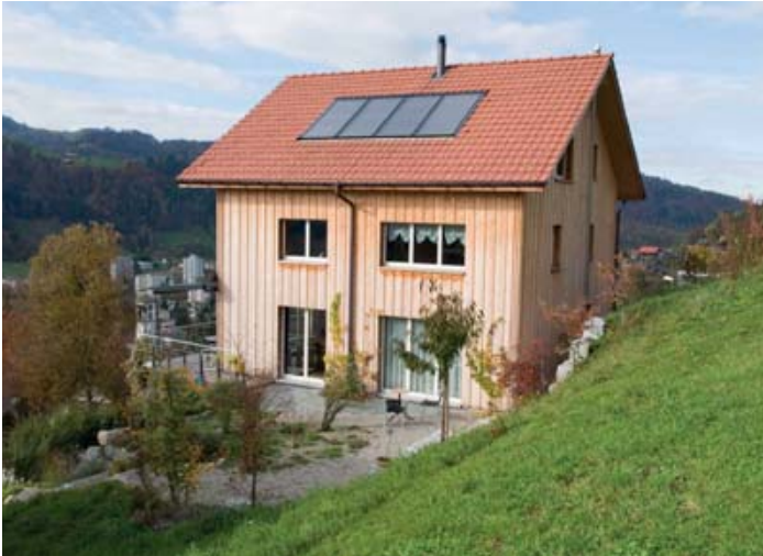
EFH-Holz – Installateur: Roth – Warmwasser + Heizung ab Sonne
