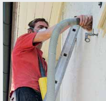
SLS 20: eine wirtschaftliche und ökologische Lösung, um Zweischalenmauerwerke nachträglich zu dämmen.
