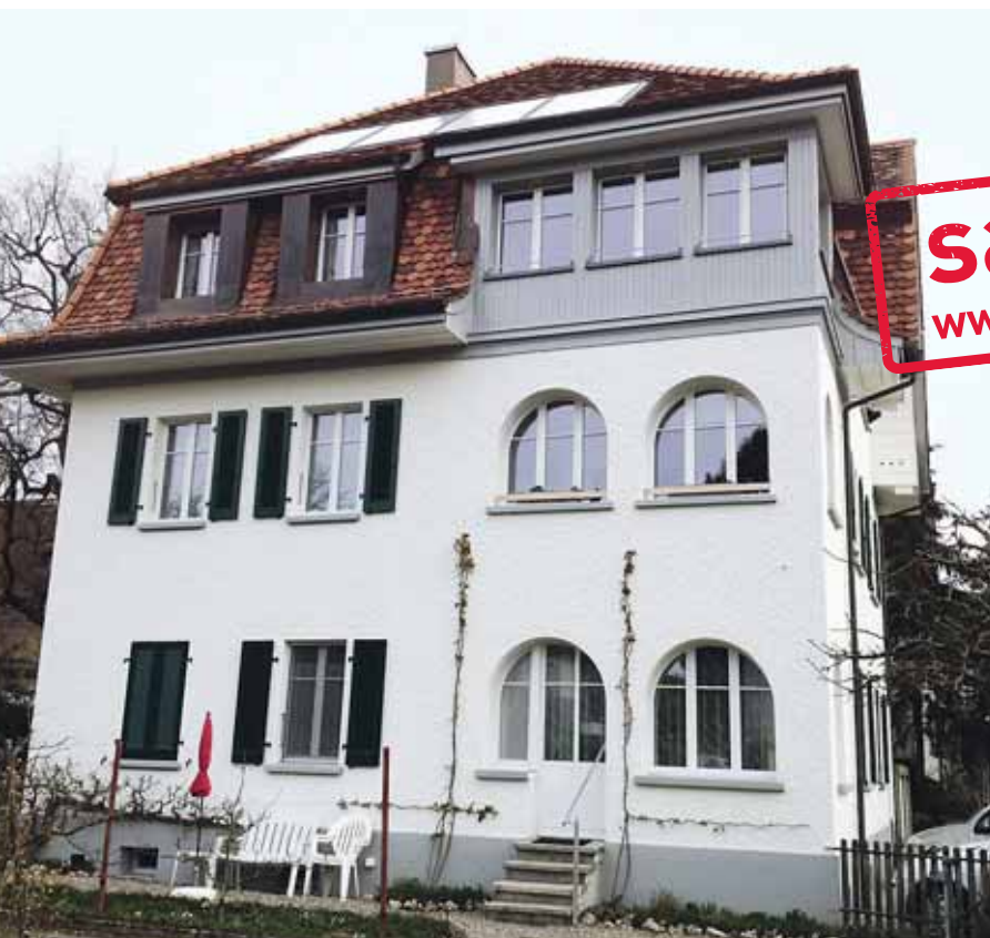
Wohnhaus in Bümpliz nach energetischer Sanierung.
