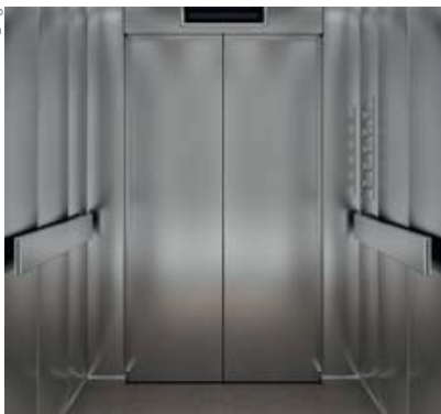
Lifteinbau: Notwendig, nützlich oder luxuriös?_15
