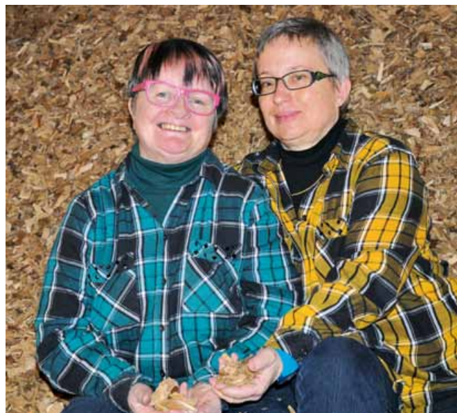
Die Hausverein-Mitglieder Marlis Grüninger (rechts) und Claudia Rohr haben ihre Ölheizung durch eine Holzschnitzelheizung ersetzt. Zehnmal pro Jahr liefert ein Lastwagen zehn Kubikmeter Holz vom Uetliberg.
