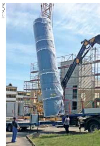
Oben: Der 10,5 Meter hohe Solarspeicher wurde mit einem grossen Kran in das dreistöckige Haus eingelassen.
