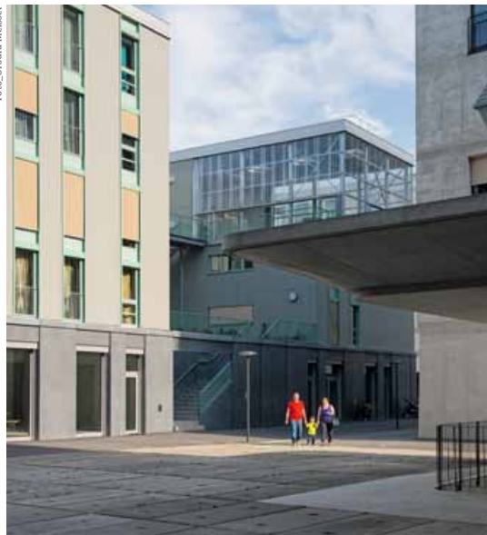
Bis vor Kurzem stellte hier die Firma Hunziker Betonplatten her. Einige liessen sich für den Platzbelag retten.
