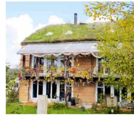
Auch schräge Dächer können begrünt werden. Hier das Beispiel von HVS-Mitglied Rosmarie Eichenberger aus Rodersdorf.
